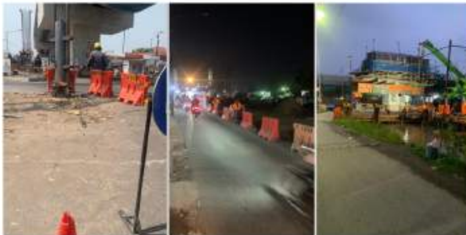
Gambar 1.2 Kondisi Proyek Konstruksi Flyover Krian
