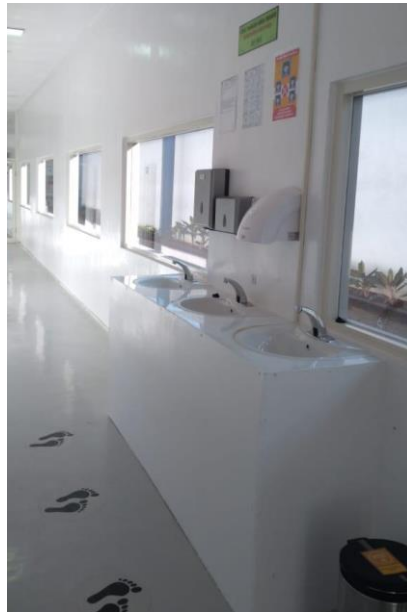
Gambar 30 Fasilitas mencuci tangan dengan sensor dan pengering tangan otomatis.
