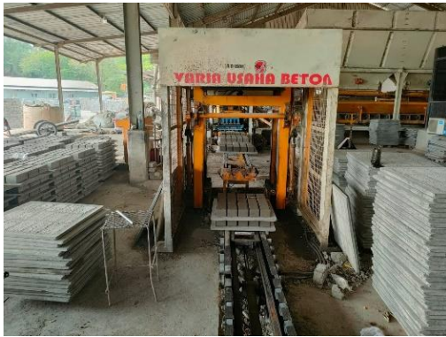
Gambar 18. Pemindahan Paving Block menggunakan Stacking Machine
