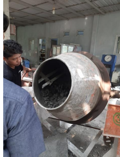
Pembuatan Beton Segar
