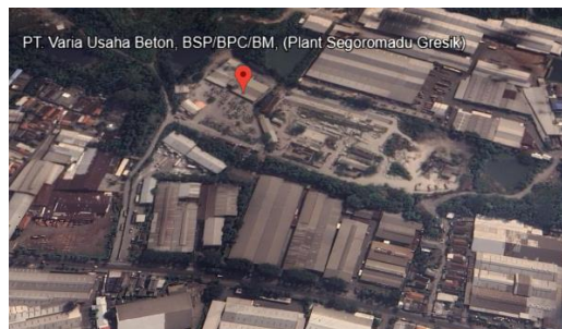
Gambar 3.3 Lokasi Pembuatan dan Pengujian Benda Uji
