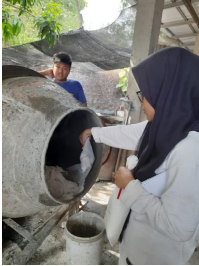
Pencampuran Material Ke Dalam Mixer
