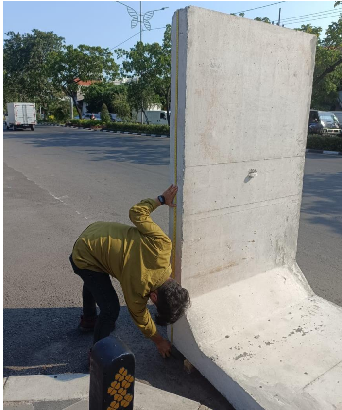
Gambar pengukuran U-ditch yang ada dilapangan
