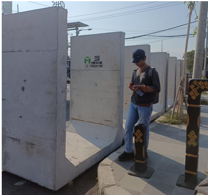
Gambar U-ditch yang ada dilapangan
