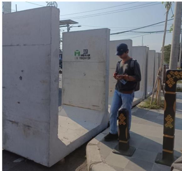
**Gambar *U-ditch* yang ada dilapangan**
