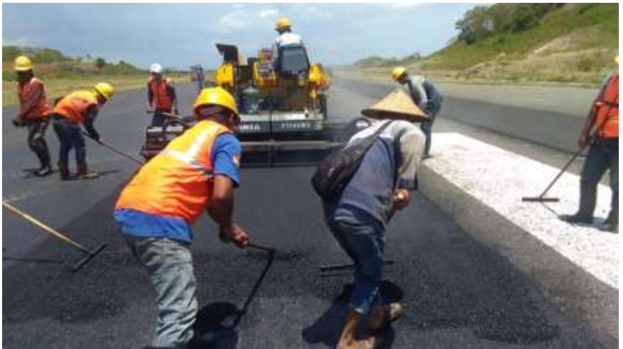
Gambar 5.1 Pekerjaan Perkerasan
