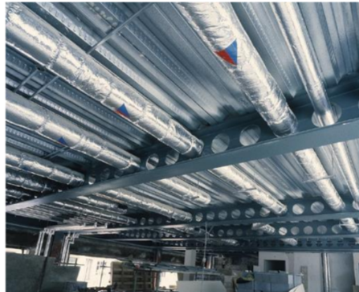
Gambar 1. Aplikasi Baja berlubang pada high rise building
