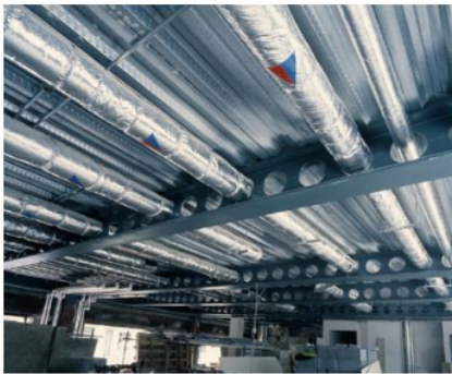
Gambar 1. Aplikasi Baja berlubang pada high rise building (sumber: http://www.steelconstruction.info )
