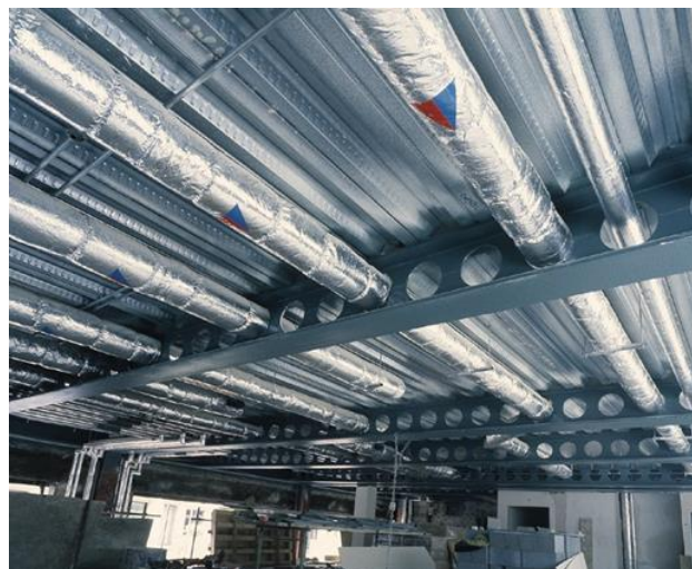
Gambar 1. Aplikasi Baja berlubang pada high rise building
